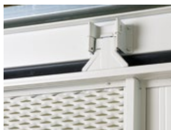
Gli autocentranti di chiusura garantiscono il centraggio dell'anta mobile per rispettare gli spazi di sicurezza.
