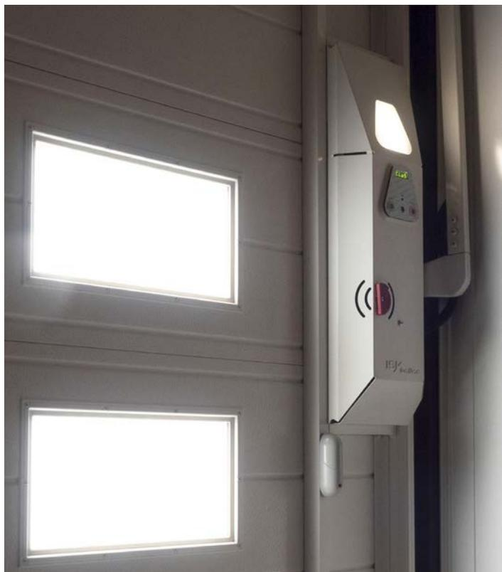
Il sensore radio è facilmente installabile sulla porta da garage e più in generale su serramenti come ad esempio porte pedonali, finestre, ecc.
